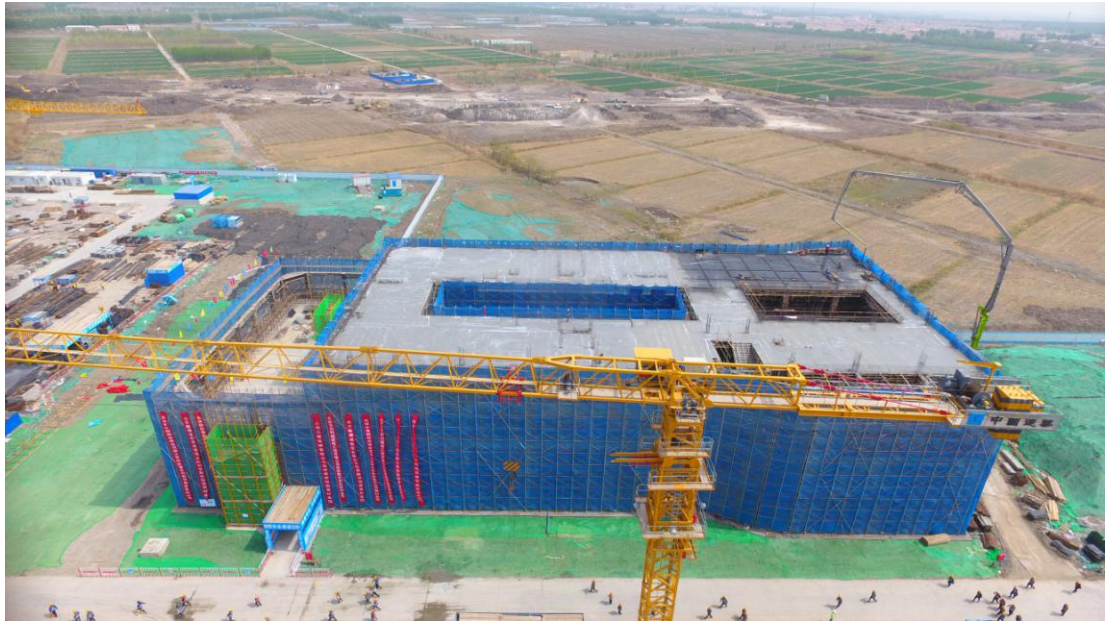
机场学院实验楼
