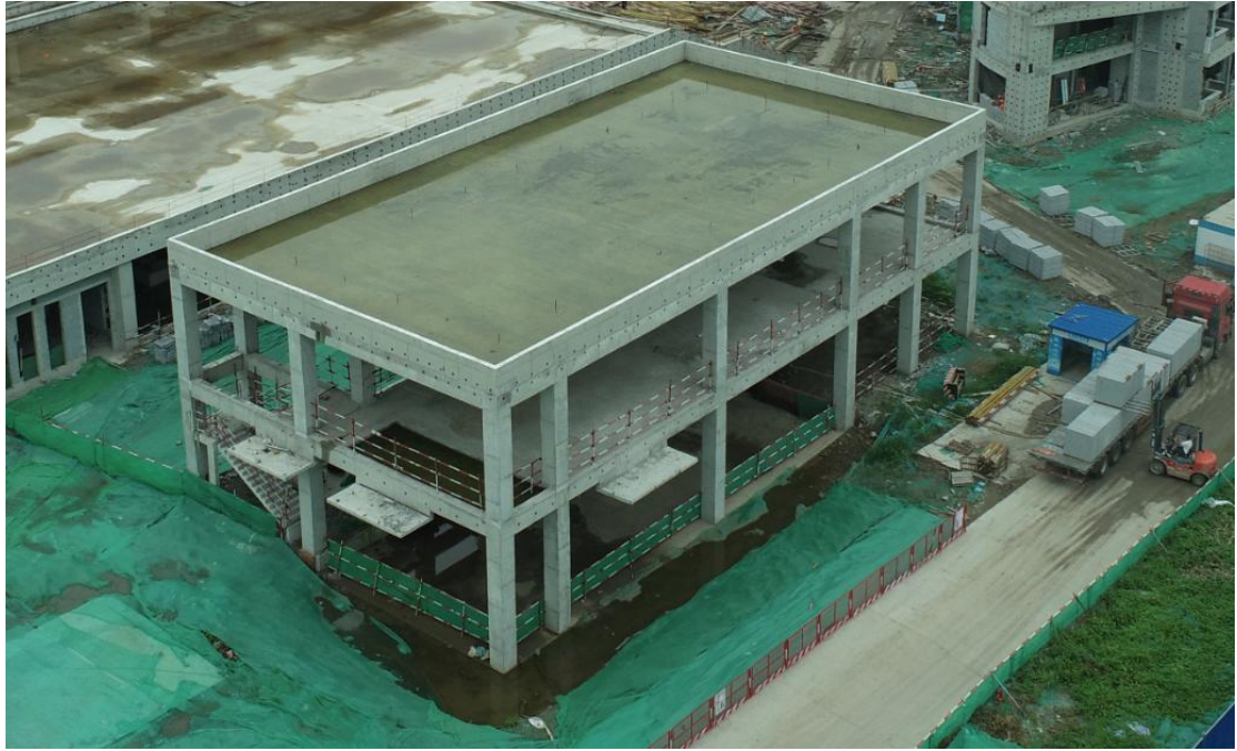
35KV 变电站主体结构施工完成
