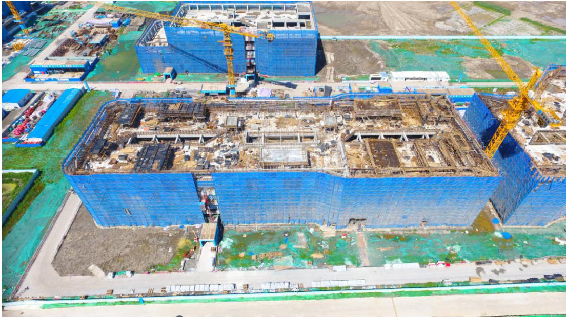
公共教学楼总体砌筑工程完成约 50%
