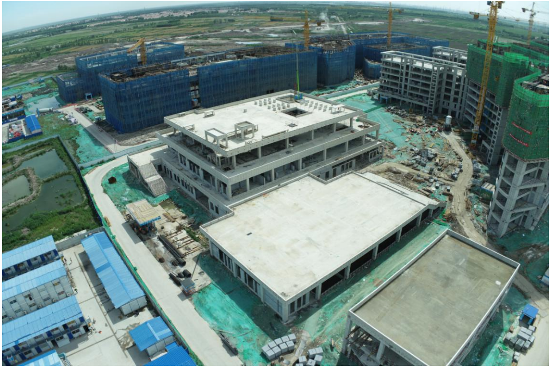
学生食堂混凝土结构完成，构砌筑完成 50%
