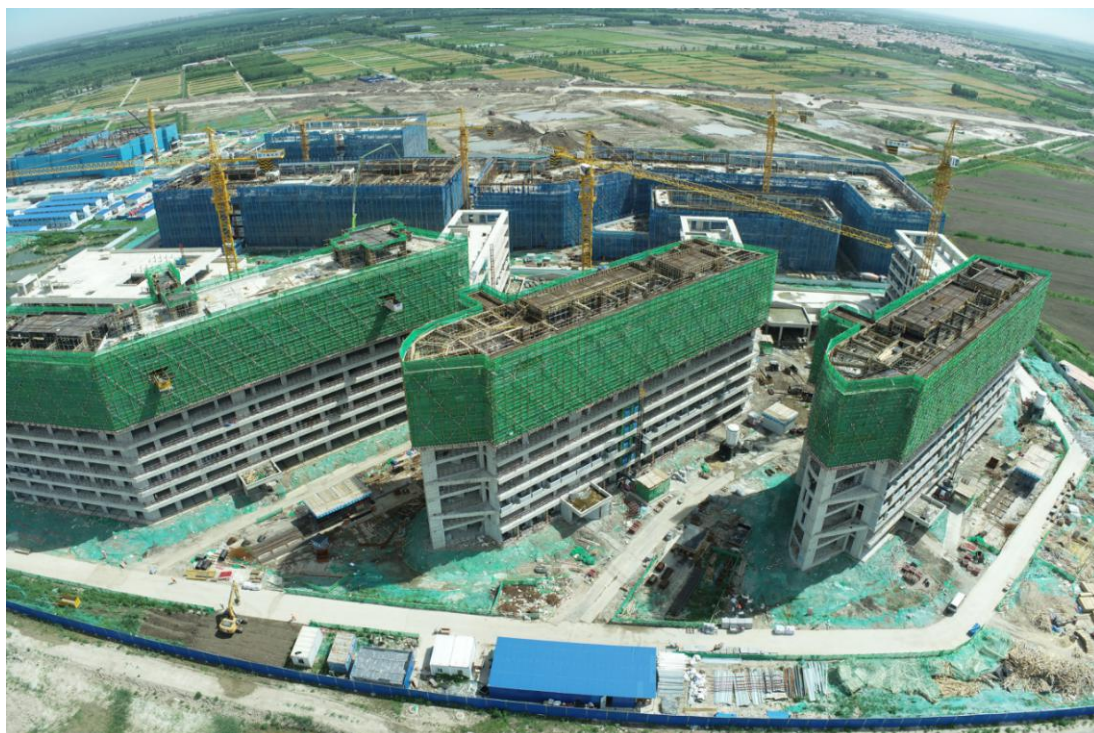
学生宿舍楼混凝土结构完成，砌筑完成约 50%
