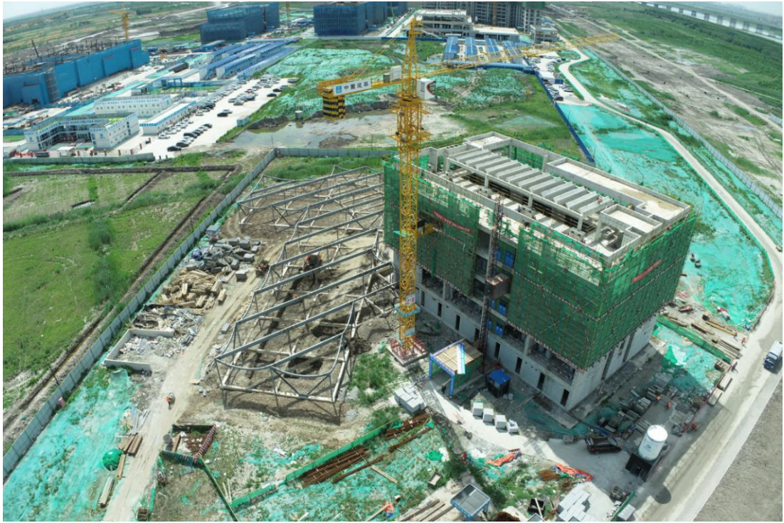
师生活动中心混凝土结构完成，构砌筑完成 75%
