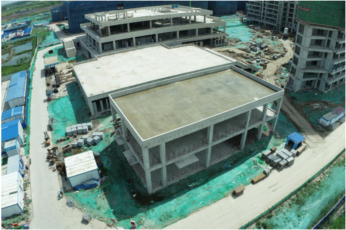
35KV 变电站主体结构施工完成
