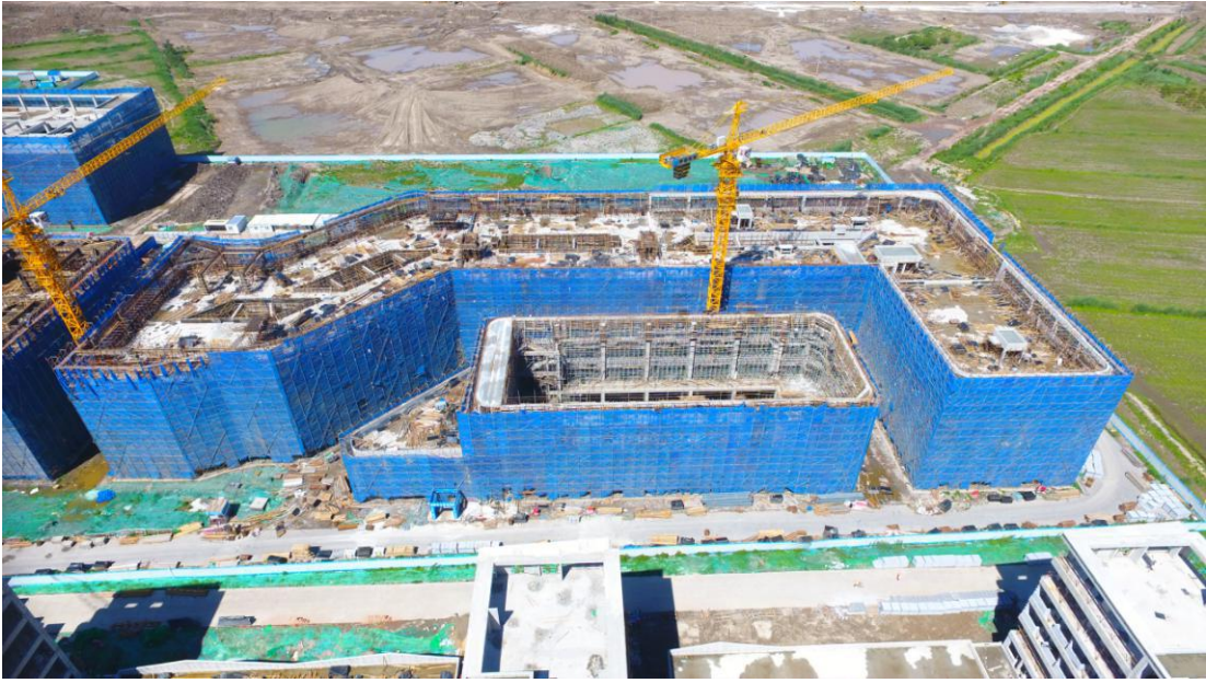
乘务飞行大楼砌筑工程完成约 50%
