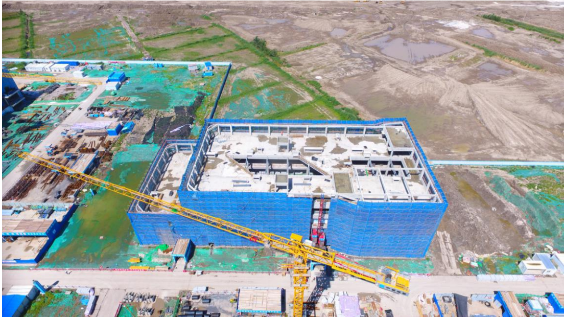
机场学院教学实验楼砌筑工程完成约 50%
