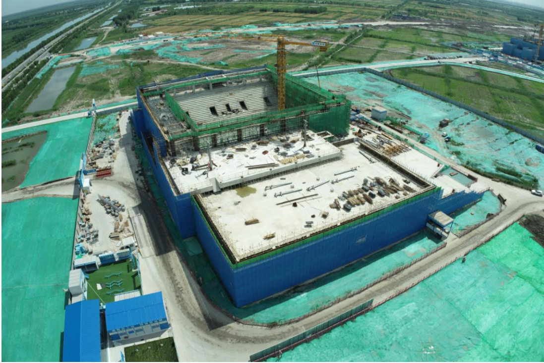
体育馆混凝土结构全部完成
