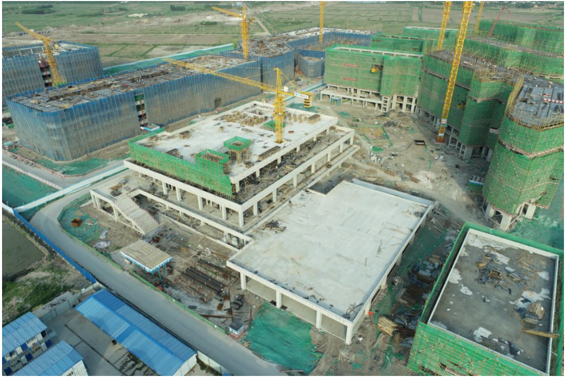
学生食堂主体结构完成。正在进行二次结构施工
