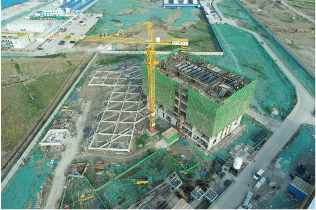
师生活动中心主体结构完成，正在进行二次结构施工
