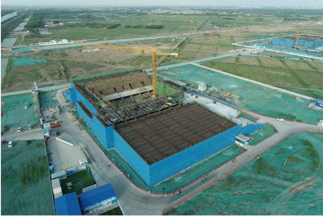
主体结构封顶，正在进行屋面花架梁施工
