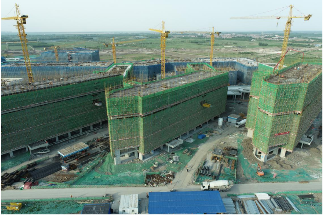
所有宿舍楼主体结构封顶
