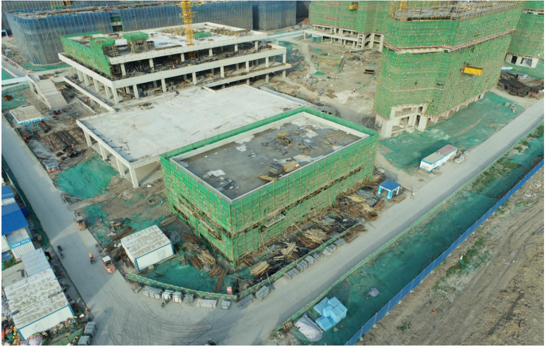
35kv 变电站，垃圾房主体结构完成
