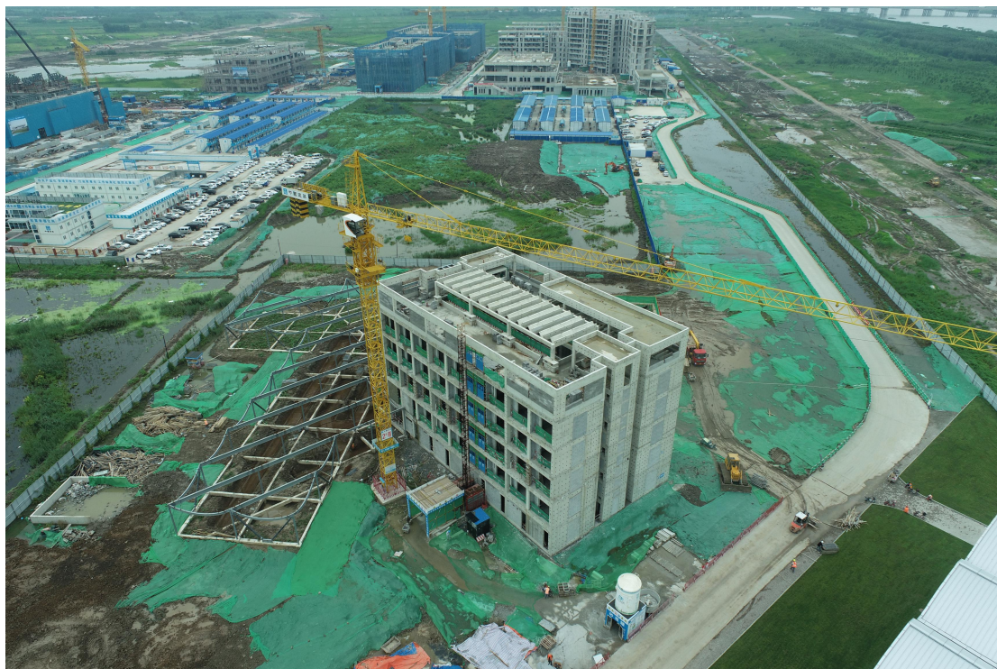
师生活动中心二次结构施工总体完成约 70%
