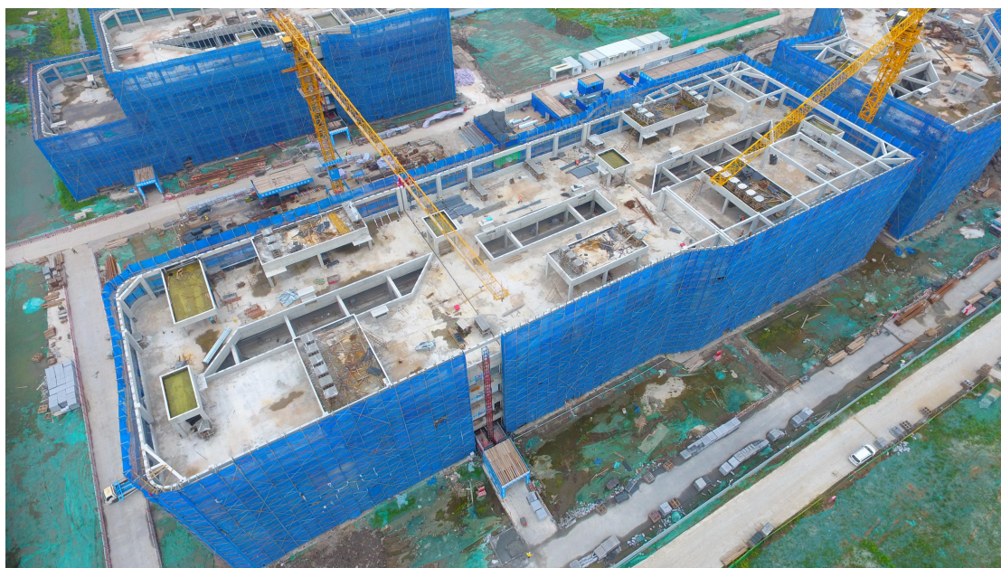
公共教学楼幕墙龙骨安装完成 80%，机电工程完成 20%，开始着手准备装修工程样板间
