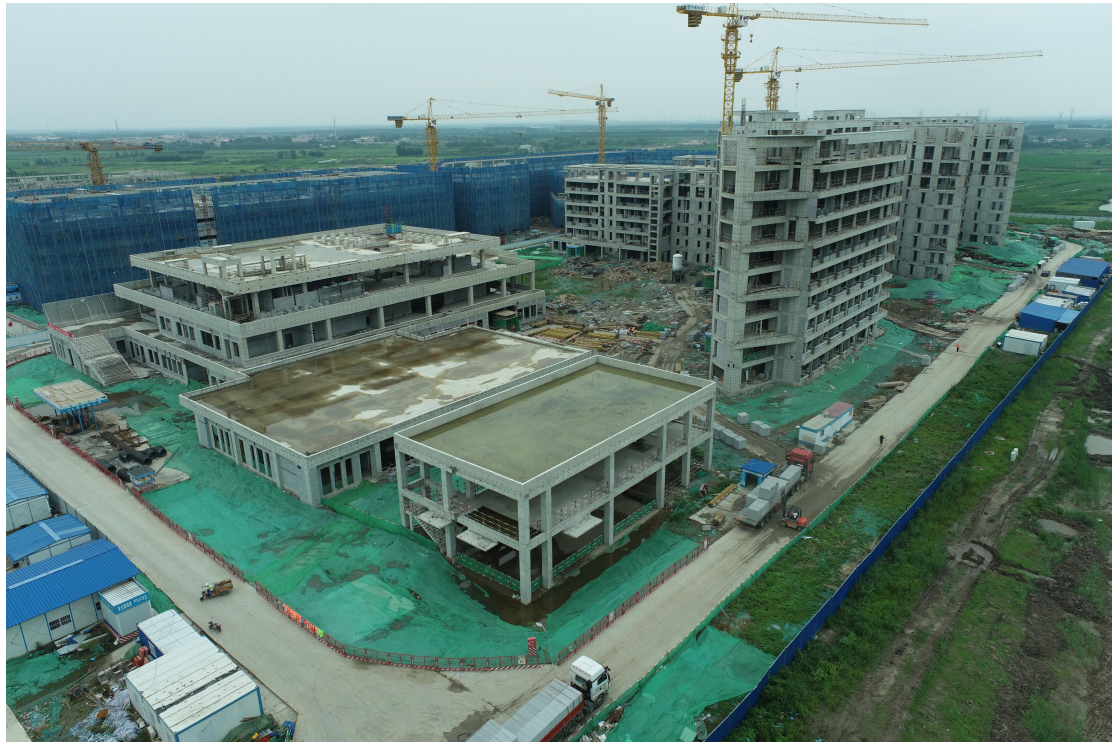
学生食堂二次结构施工总体完成约 70%
