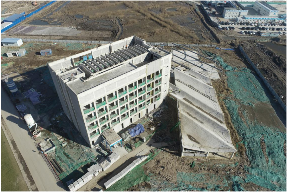
师生活动中心屋面施工完成，全面展开外墙保温施工。
