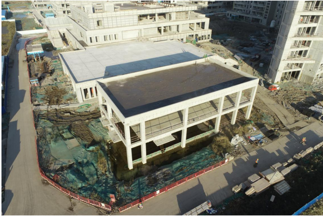
35KV 变电站主体结构施工完成
