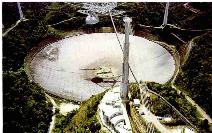
▲ 阿雷西博射电望远镜, 口径 305 米
