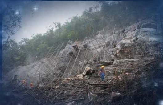
洼坑锚喷支护施工
