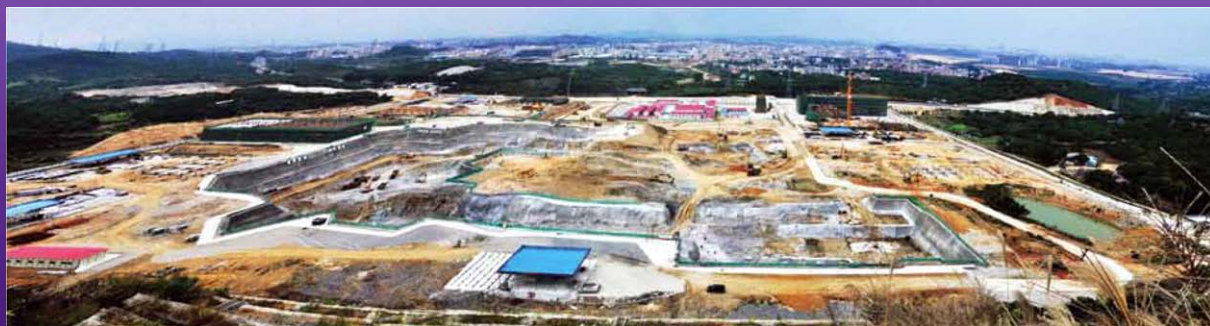
2012年11月，中国散裂中子源工程现场，基坑开挖即将结束
