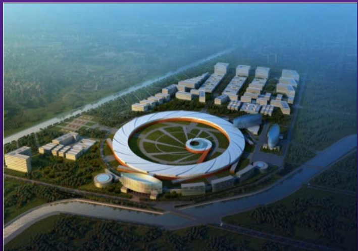
正在设计和研究的北京先进光源 BALS 是一台高能量（5 GeV）、高亮度（电子束流强 200 mA，发射度优于 0.5 nm·rad）的同步辐射光源，是规划中的北京综合研究中心的核心设施，用以满足我国科技前沿研究、国家重大战略目标和自主创新研究的广泛和迫切需求。
