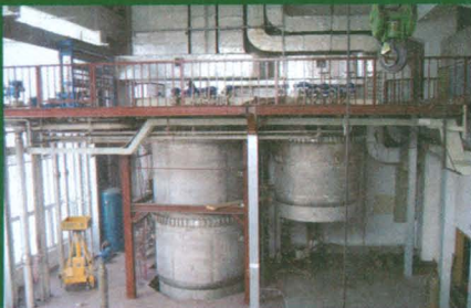
2 kW/4.5 K 低温和制冷系统
